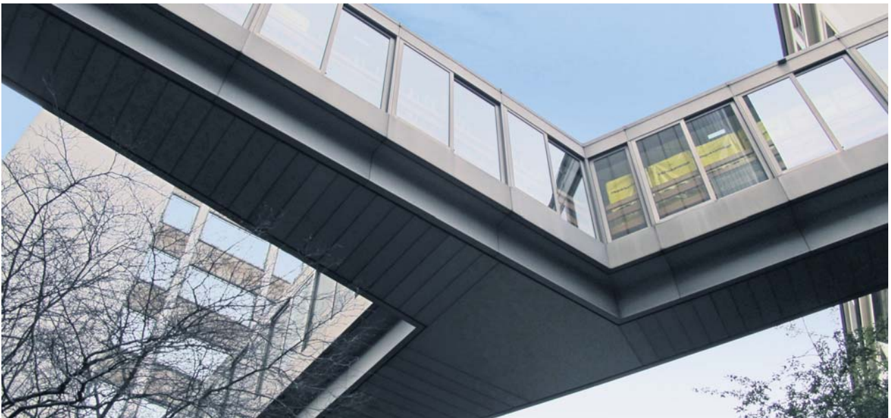
Immobilien aus den 70er Jahren verlangen den Asset-Managern alles ab. Für das ehemals von der R+V-Versicherung genutzte Gebäude in Wiesbaden prüfte Eigentümer IFM etliche Sanierungs- und Umbau-Varianten. Jetzt wird der Abriss vorbereitet. Bild: api
