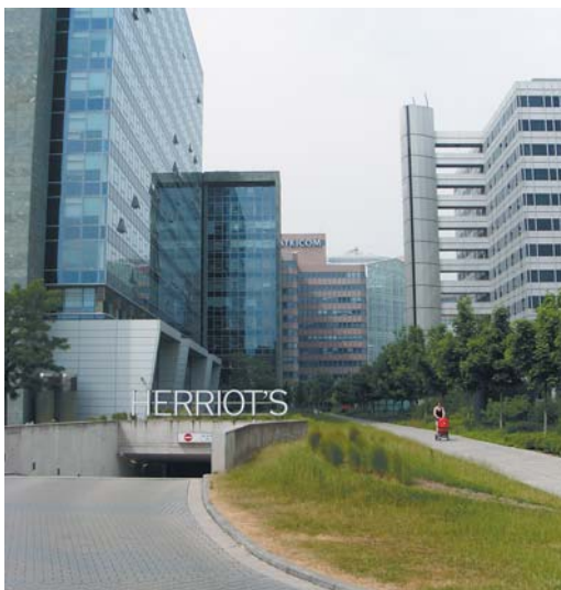
Die Frankfurter Bürostadt Niederrad ist gleichermaßen eine Herausforderung für das Asset-Management, für Property-Manager und FM-Dienstleister. Bild: law
